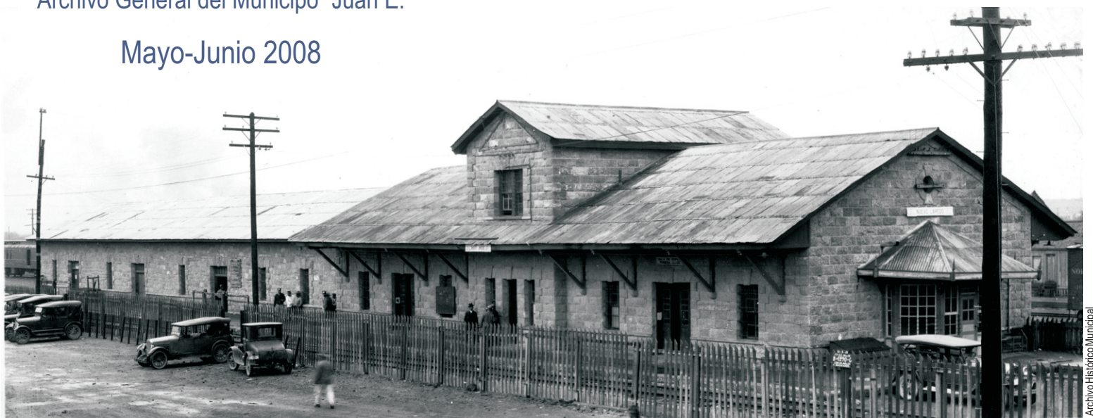
Frente de la Estación del Ferrocarril hacia lado norte. Parte de dos pisos, para oficina de la estación, telégrafos, sala de espera, salas de revisión y oficina de equipajes (1926).
