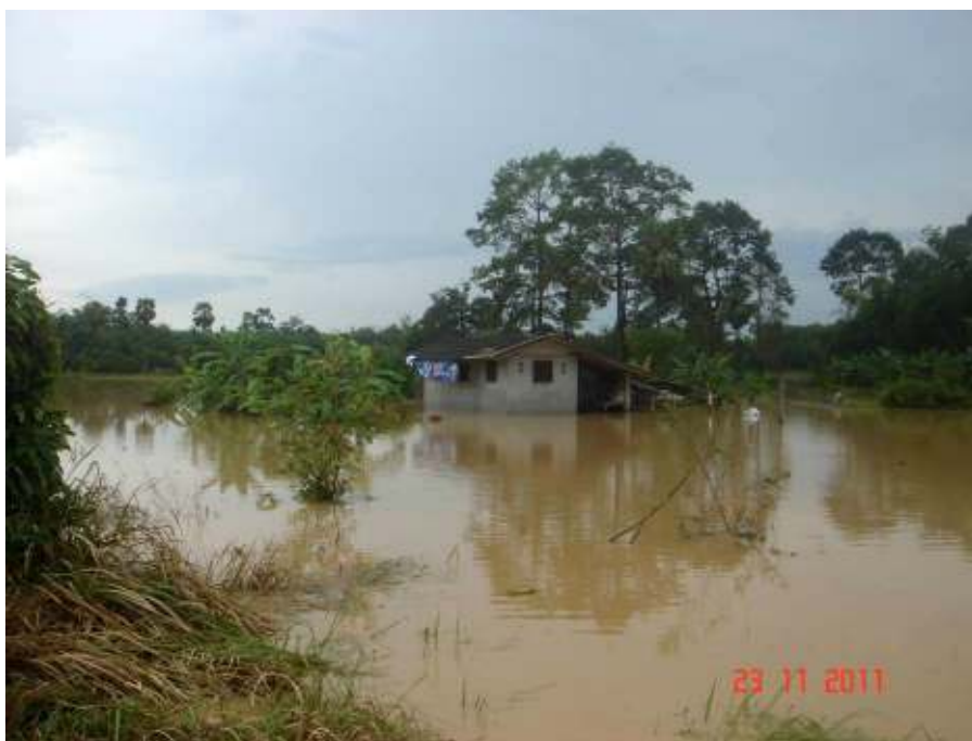
หมู่ 1 บ้านป่าเว ริมถนนเอเชีย ต.ป่าเว อ.ไชยา จ.สุราษฎร์ธานี น้ำท่วมสูงประมาณ 30 ซม. ถ่ายเมื่อวันที่ 23 พฤศจิกายน 2554
