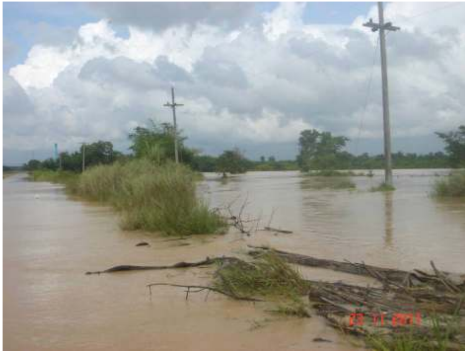
คลอง RMC ช่วง กม.7+900 - 8+300 อ.ไชยา จ.สุราษฎร์ธานี น้ำท่วมสูงประมาณ 0.80 - 1.00 ม. ถ่ายเมื่อวันที่ 23 พฤศจิกายน 2554
