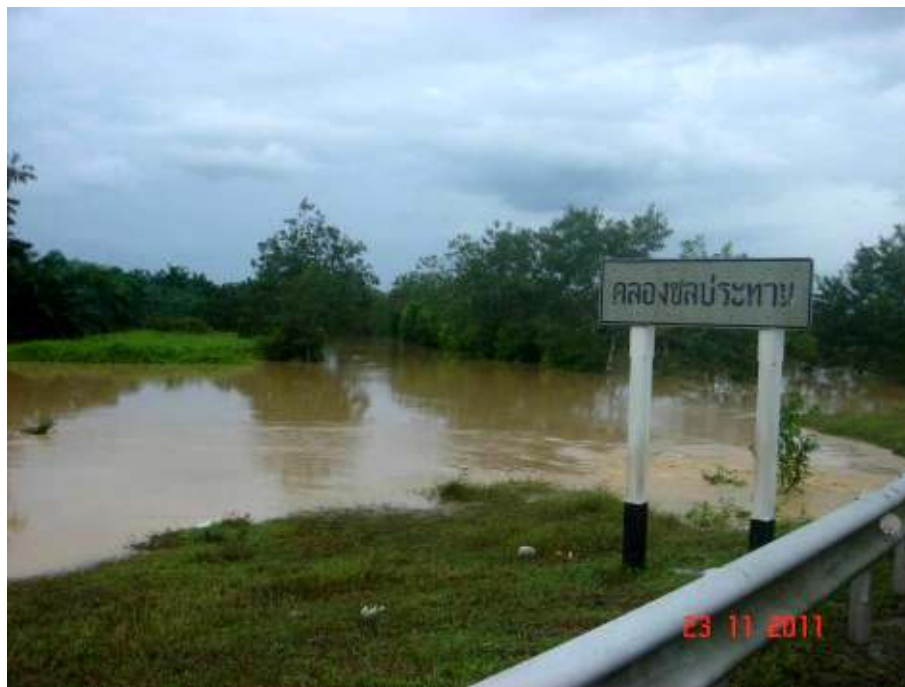
คลองส่งน้ำ คลอง 1R-LMC กม.3+300 ต.ป่าเว อ.ไชยา จ.สุราษฎร์ธานี น้ำท่วมบนถนนลูกรังสูงประมาณ 0.30 ซม. ถ่ายเมื่อวันที่ 23 พฤศจิกายน 2554
