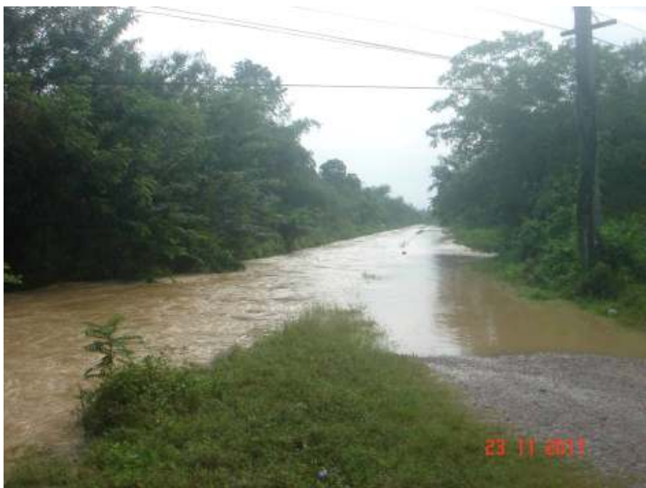
คลอง 1R-LMC ช่วง กม.3+300 - 4+500 ต.ป่าเว อ.ไชยา จ.สุราษฎร์ธานี น้ำท่วมสูงประมาณ 30 ซม. ถ่ายเมื่อวันที่ 23 พฤศจิกายน 2554
