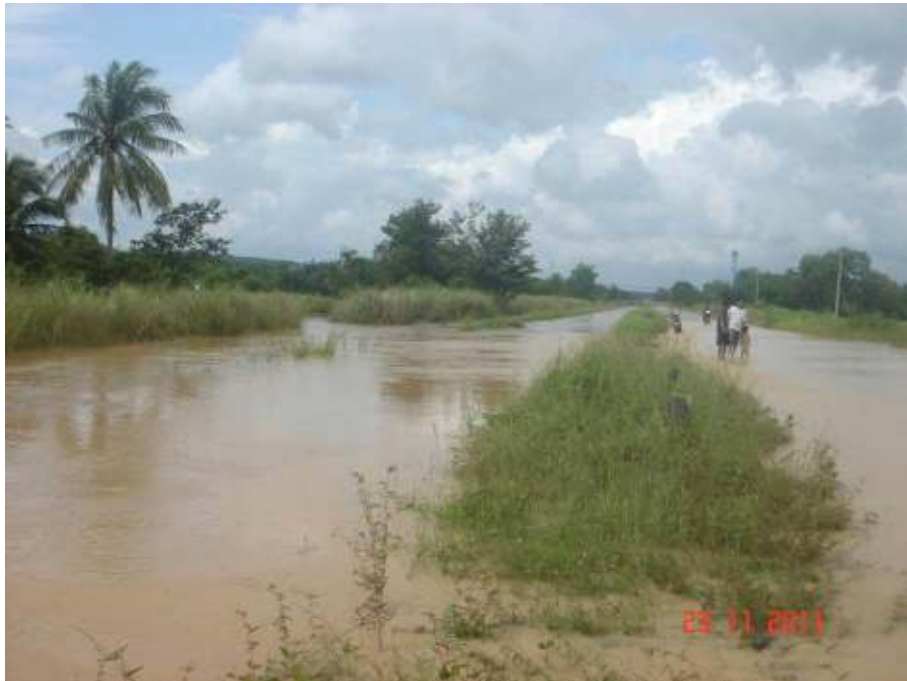
คลองส่งน้ำ - ถนนคันคลองและถนนลาดยางของคลอง RMC อ.ไชยา จ.สุราษฎร์ธานี น้ำท่วมสูงประมาณ 30 ซม. ถ่ายเมื่อวันที่ 23 พฤศจิกายน 2554
