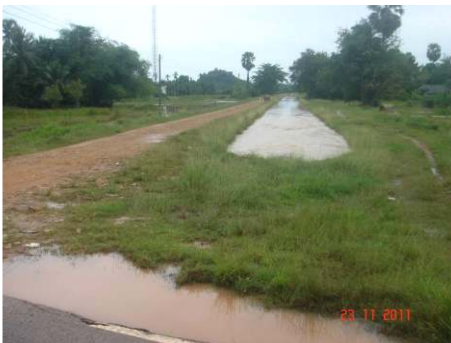
สภาพน้ำเต็มคลองส่งน้ำ 1R-RMC ต.ป่าเว อ.ไชยา จ.สุราษฎร์ธานี ถ่ายเมื่อวันที่ 23 พฤศจิกายน 2554
