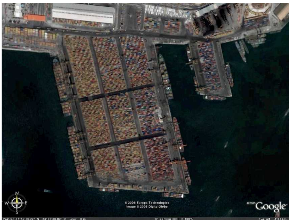
Σχήμα 3.1.1-6 Δορυφορική λήψη του Ε/Κ σταθμού Ελ. Βενιζέλος στον Πειραιά
