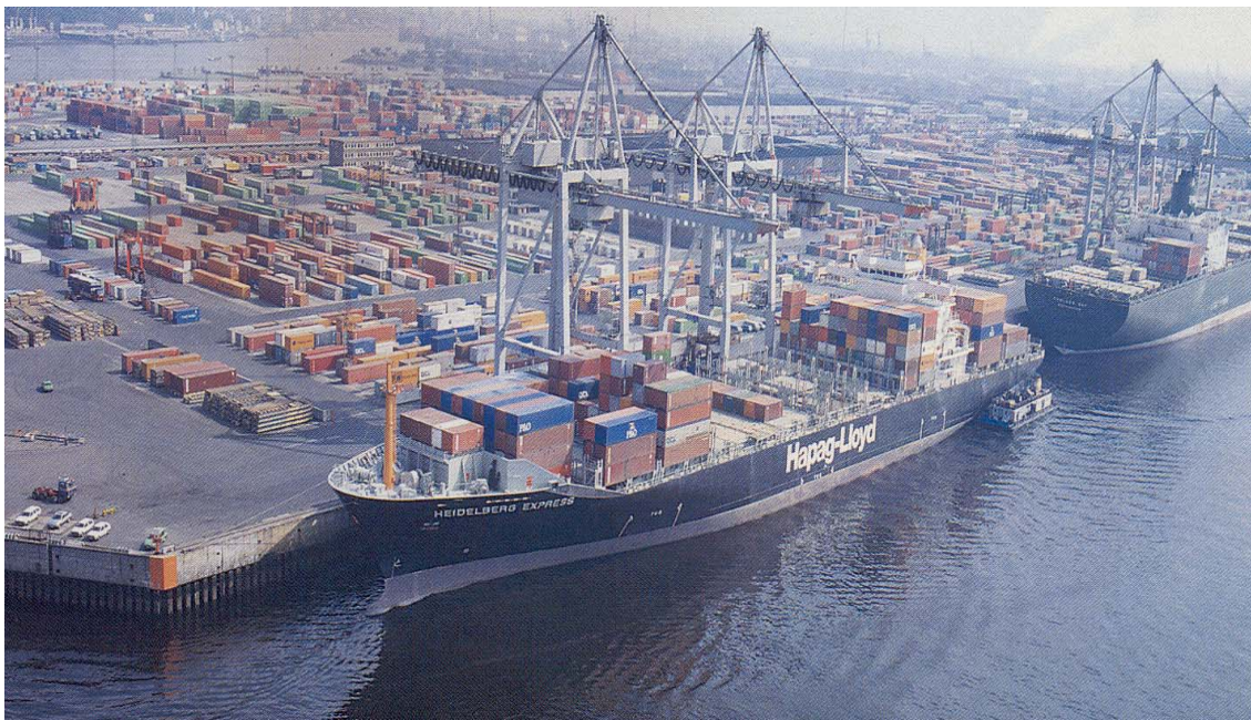
Εικόνα τυπικού λιμένα διακίνησης εμπορευματοκιβωτίων. Διακρίνονται οι γερανογέφυρες επί του κρηπιδώματος στις θέσεις παραβολής των πλοίων και η διάταξη των εμπορευματοκιβωτίων στους χώρους εναπόθεσης/στοιβάσεως
