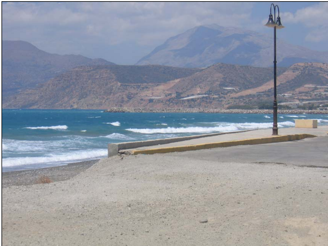
Φ11: Παραλιακός δρόμος στην προκυμαία του Κόκκινου Πύργου. Στο βάθος διακρίνεται η θέση κατασκευής του έργου.
