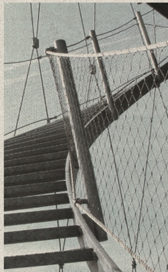
Parapetto con rete acciaio INOX
