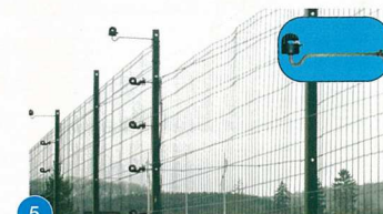
4 Isolateurs sur structure grillagée
