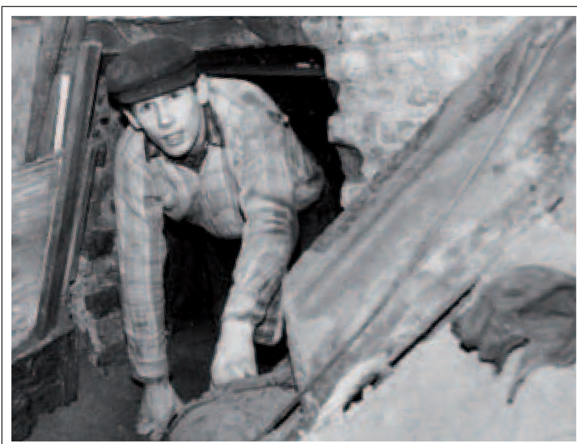
UNTERTAGE-BAU Bruno Becker hat als einer der ersten Berliner die Idee, die Mauer zu untertunneln. 28 Menschen, vor allem seine Familie, nutzen am 30. Januar 1962 die Chance zur Flucht
