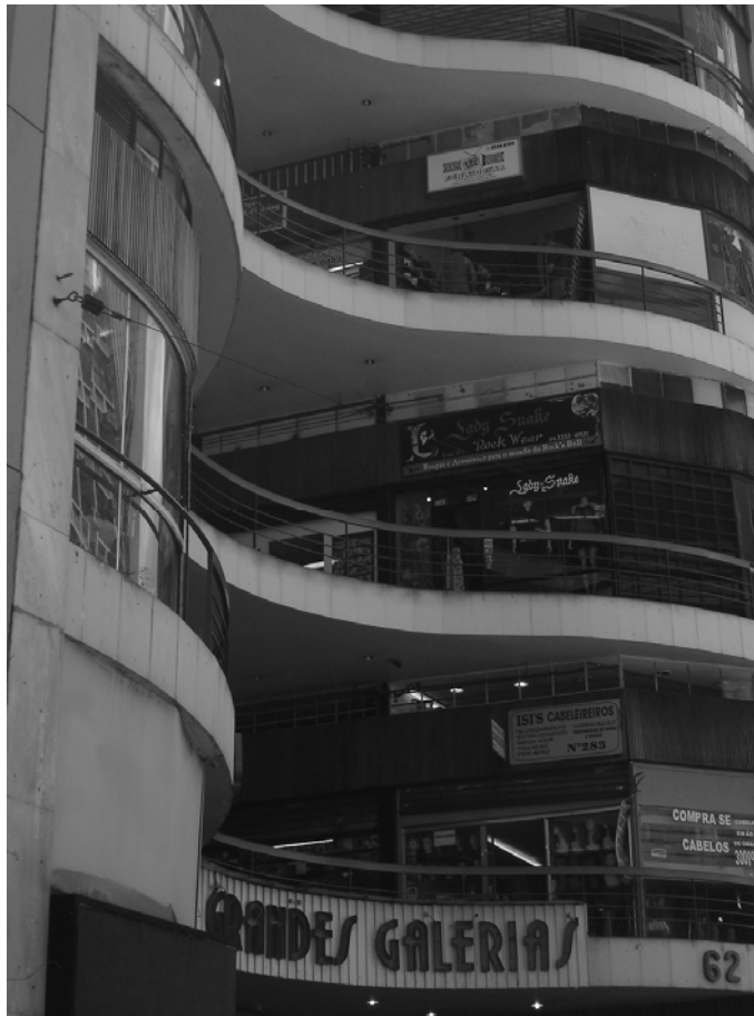
Grandes Galerias São Paulo Desenho sinuoso das lajes convida ao acesso. Fonte: imagem do autor, 2008.
