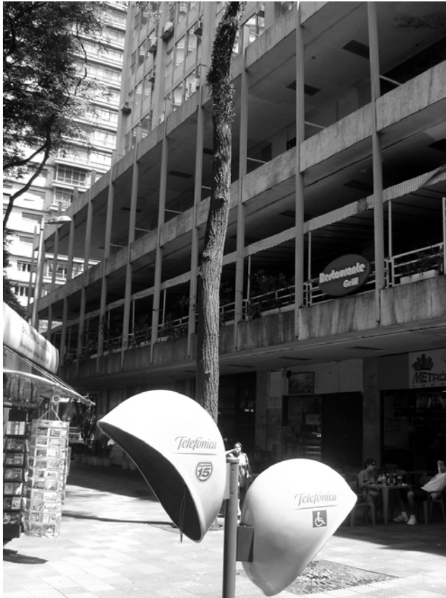
Edifício Metrópole São Paulo Vista desde a praça D. José Gaspar: balanço sobre a praça. Fonte: imagem do autor, 2008.
