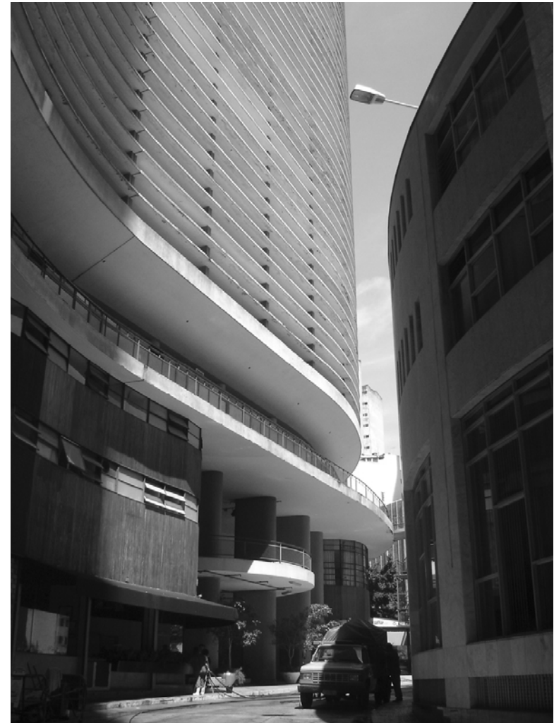
Edifício Copan São Paulo Vista desde a rua interna, rua Unáí Fonte: imagem do autor, 2008.
