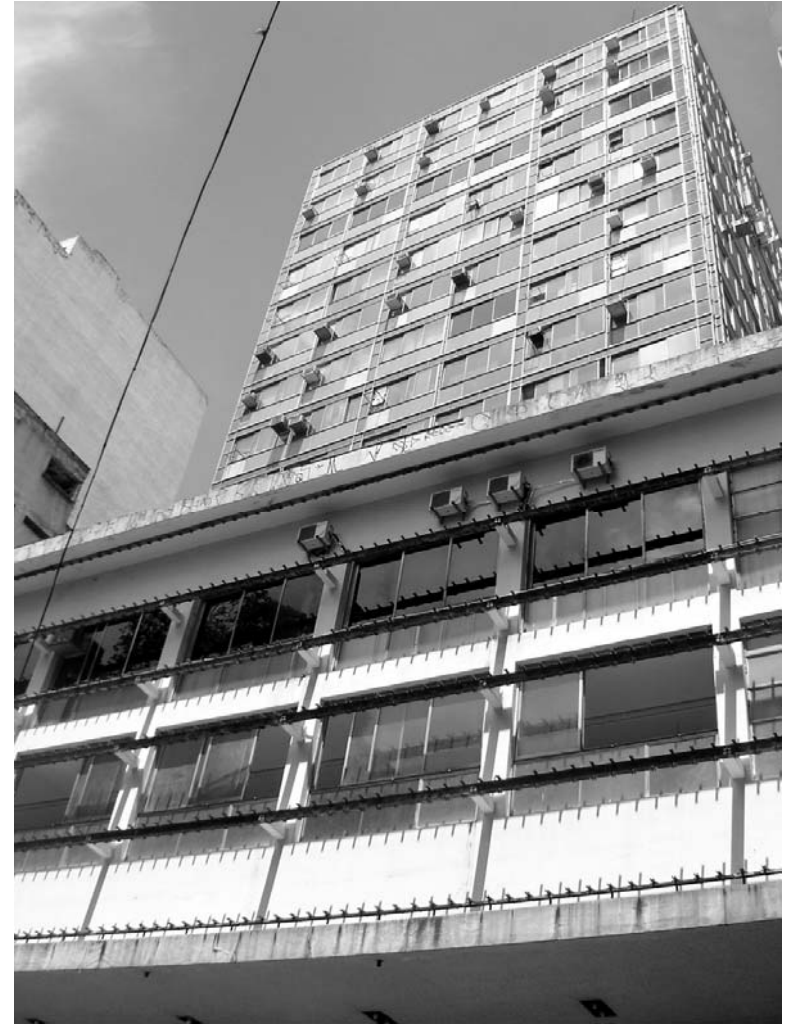
Edifício R. Monteiro São Paulo A torre de escritórios isolada, soltando-se dos recuos. Fonte: imagem do autor. 2008.
