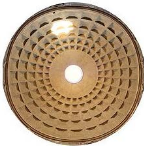
Figura P6. Vista interna da cúpula do Pantheon
