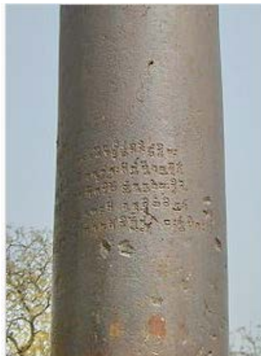
Figura D2. O obelisco de Delhi é conhecido pela ausência de oxidação devido ao hidrogeno fosfato de ferro resultante do teor elevado fosforo no ferro.
