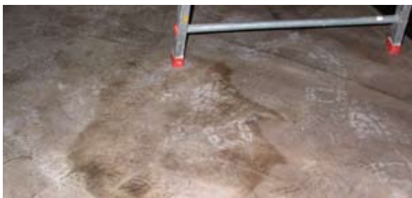
Onbeschermde vloer tijdens werkzaamheden
