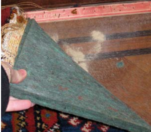
Zandophoping onder een tapijt is erger dan geen tapijt
