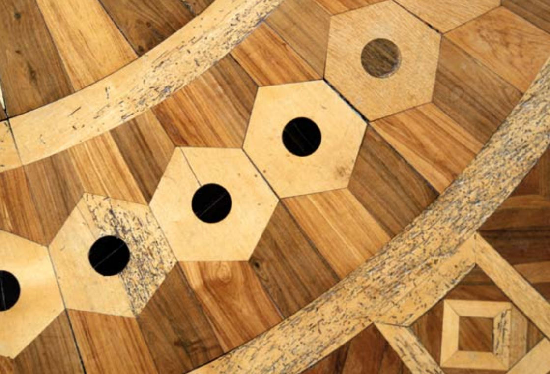
Opengeschuurde boorgangen van de kleine klopper
