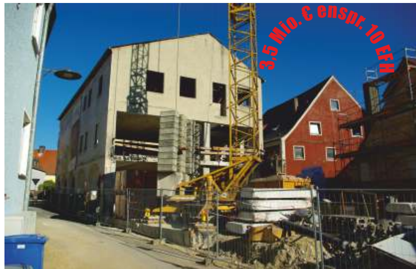
Baustelle Storchen - an diesen Anblick müssen wir uns gewöhnen!
