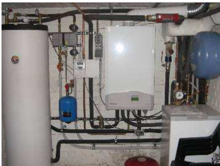
Volledige isolatie in de kelder
