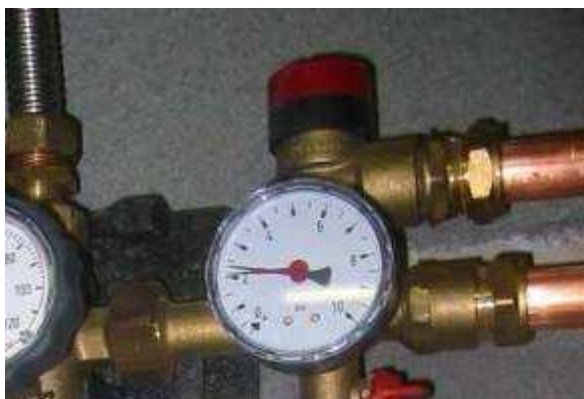
Manometer en veiligheidsklep
