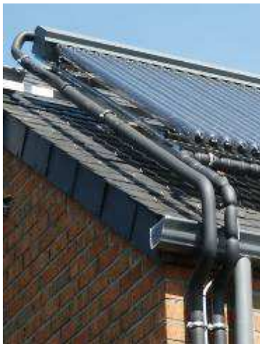
Volledige isolatie op het dak
