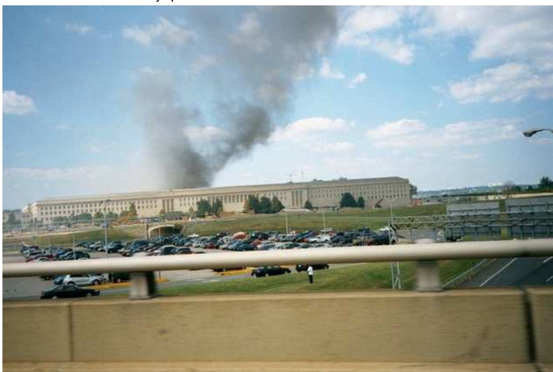
Fumaça no prédio do Pentágono.
