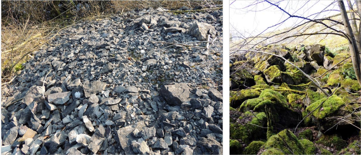
Figure 60 : Éboulis de pierres et moellons appartenant au versant ouest de la fosse ; Coulée de blocs
