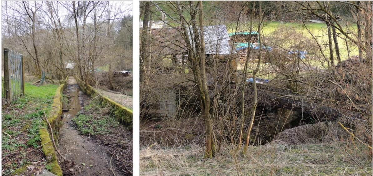
Figure 40 : Bief construit par la firme Mahaux ; Roue à augets
