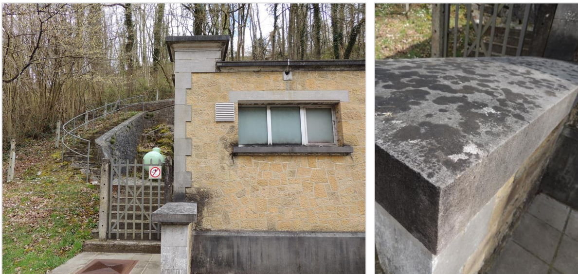
Figure 22 : Bâtiment de l'intercommunale bruxelloise des eaux (construit en 1915) 13 ; Dalle de recouvrement en petit granit
