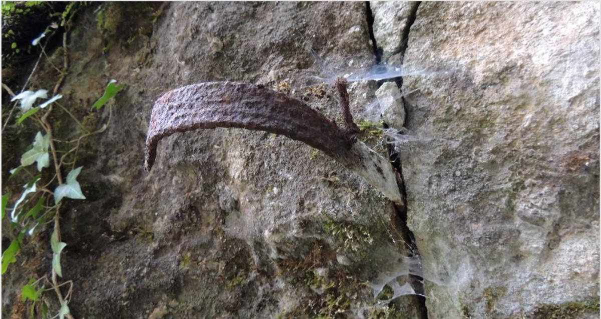
Figure 50 : Barre de métal coincée dans la roche
