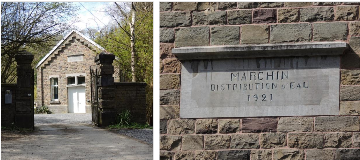
Figure 55 : Bâtiment rénové ; Inscriptions sur la pierre : « MARCHIN DISTRIBUTION D'EAU 1921 »
