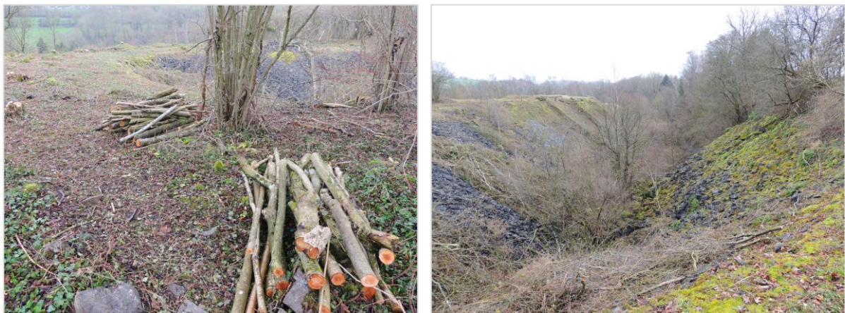
Figure 73 : Élimination des ligneux ; Versant et plateau dégagés (les branches et les troncs ont été jetés dans l'ancienne fosse d'extraction 82 )
