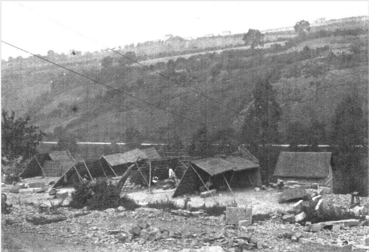
Figure 52 : Chantier de taille appartenant au versant sud de la vallée
