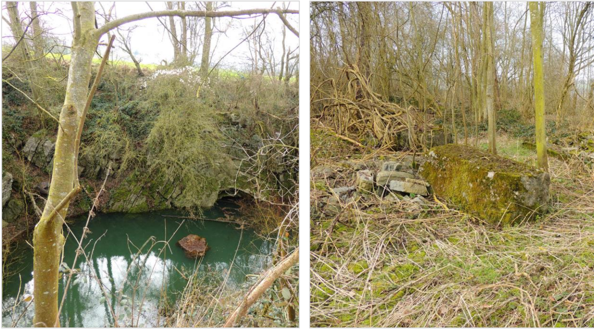
Figure 59 : Accumulation d'une eau verdâtre ; Blocs de pierre 71 laissés sur place
