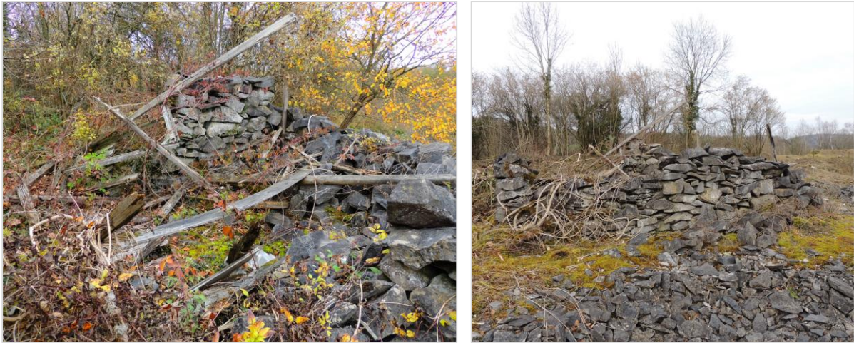
Figure 72 : Fondation d'une ancienne maisonnette en pierre bleue
