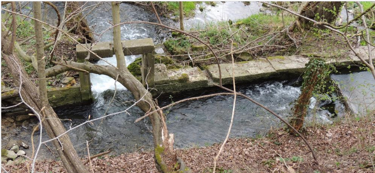
Figure 39 : Barrage de pierres vu de la route
