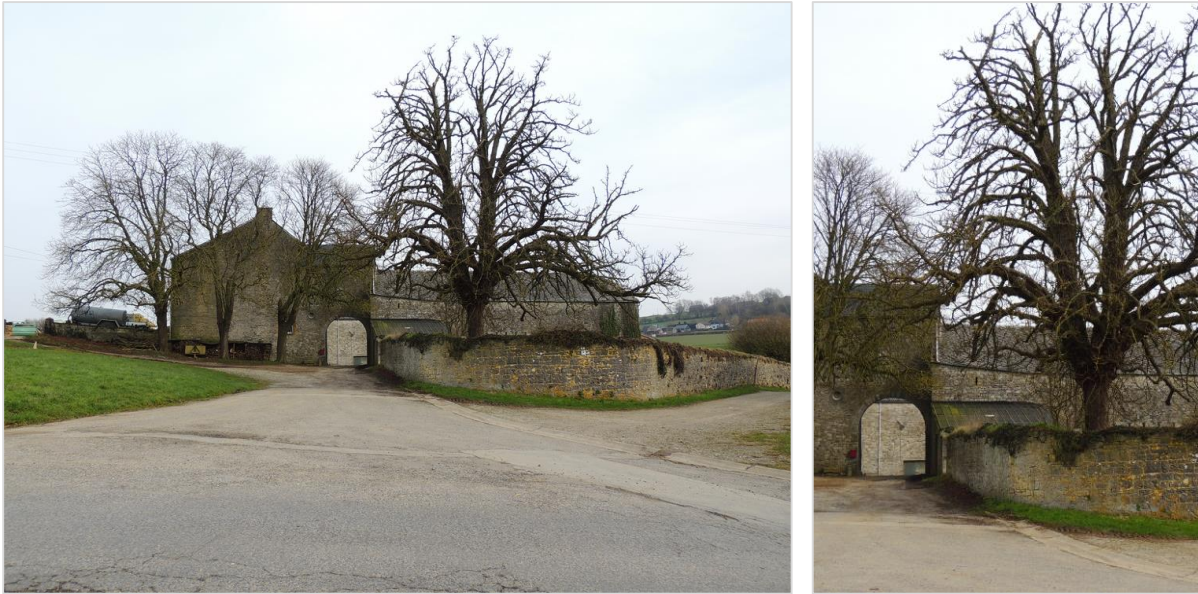
Figure 26 : Grande ferme en pierre bleue ; Entrée
