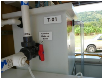
Válvula de manejo automático por cambio de presión interna en el sistema de retro lavado y cámara de aplicación de sal para preparación de cloro.
