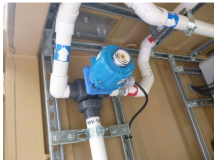
Válvula de manejo automático por cambio de presión interna en el sistema de retro lavado y cámara de aplicación de sal para preparación de cloro.
