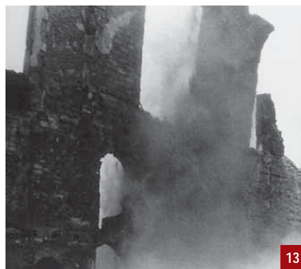
[13] Abbrucharbeiten im Dezember 1962
