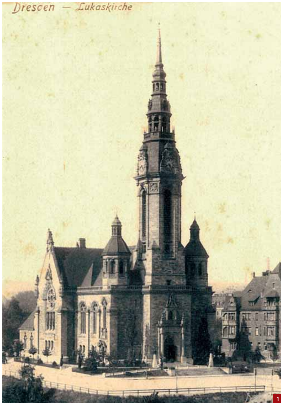
[1] Die Lukaskirche von der Werderstraße aus gesehen, 1905
