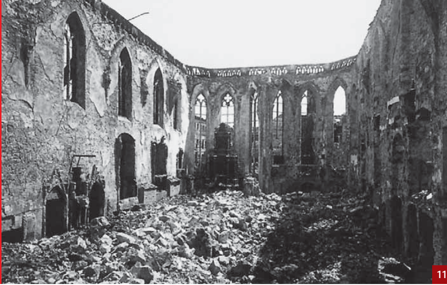
[11] Die Sophienkirche nach dem Einsturz der Gewölbe
