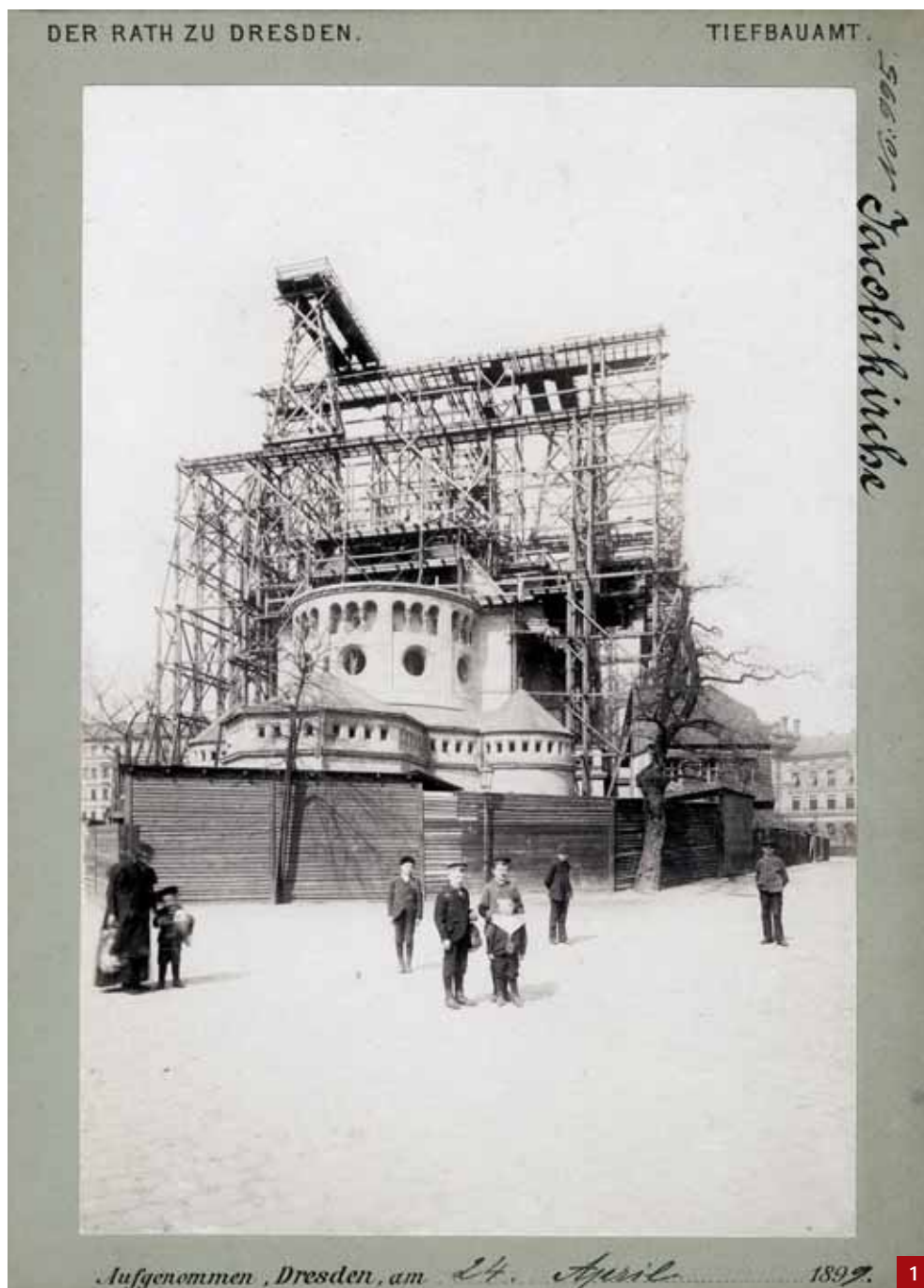
[1] Die Jakobikirche wird gebaut, Foto vom 24. April 1899.
