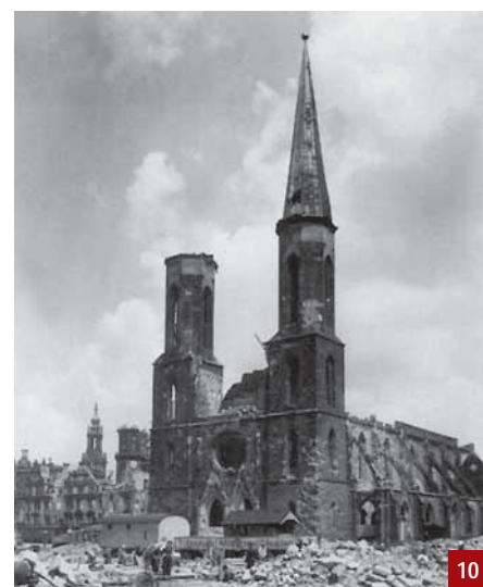
[10] Die Ruine der Sophienkirche mit Blick vom Postplatz
