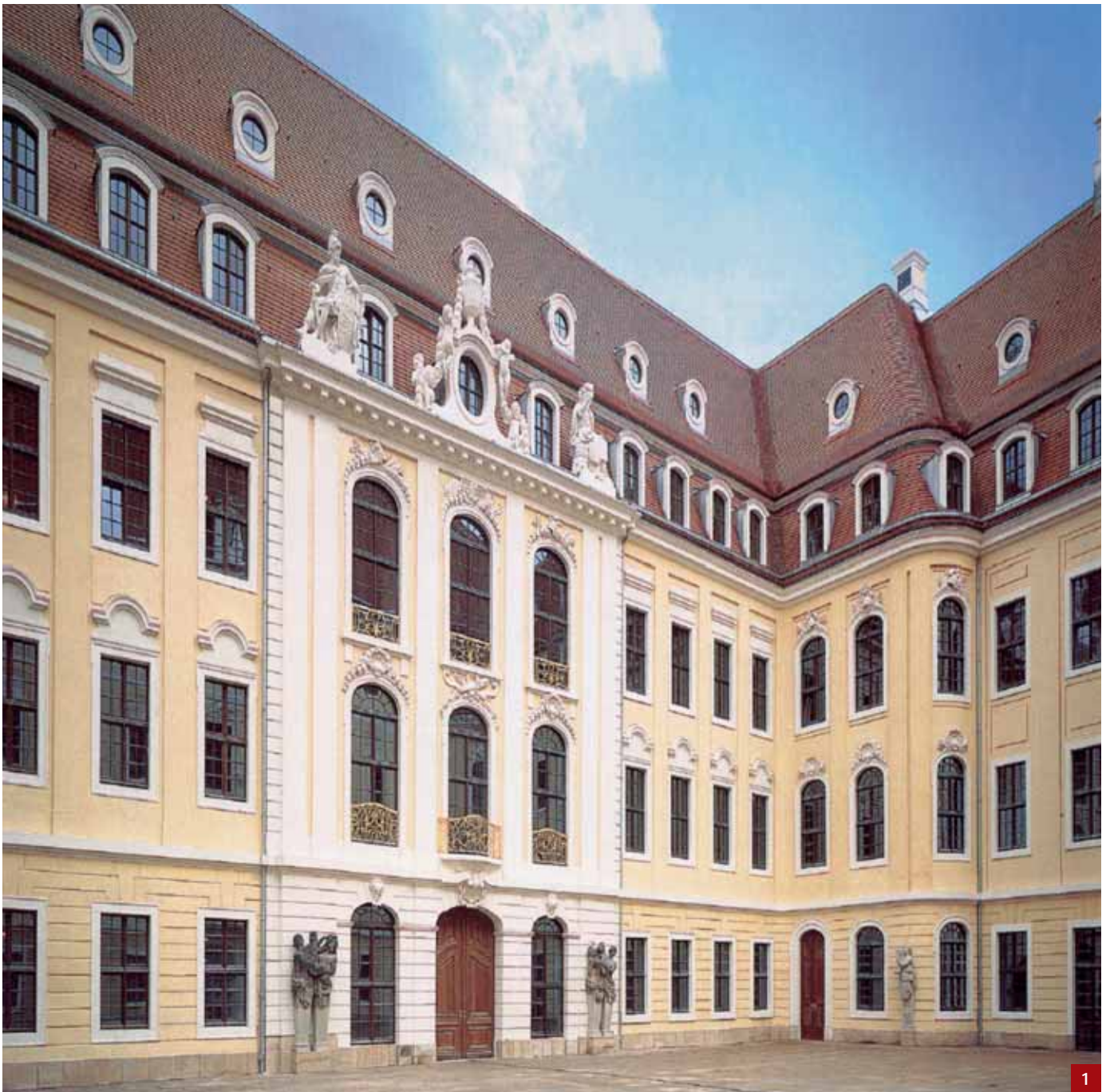
[1] Der Innenhof des Hotels 2007, Blick nach Südwesten
