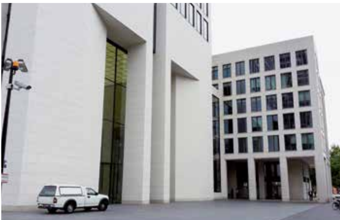
Opernturm, Frankfurt – Graffiti-Schutz mit SEMI-Guard
