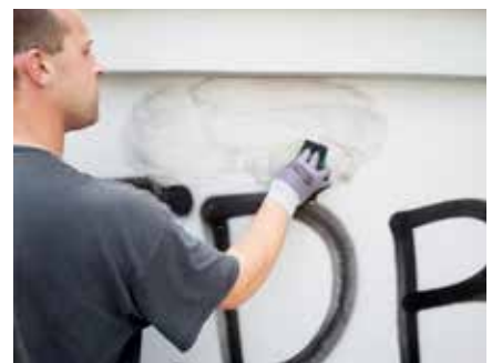
2. Einarbeiten des Graffiti-Entferners mittels Schwamm
