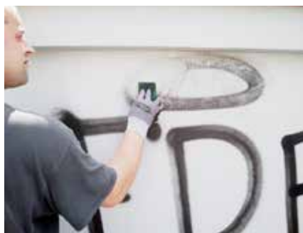
1. Auftragen des umweltfreundlichen Graffiti-Entferners
