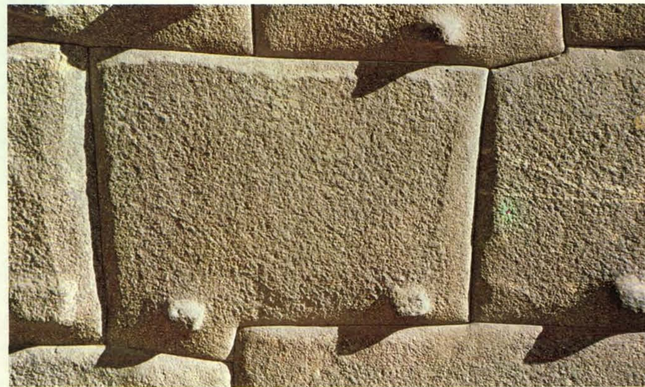
Nel particolare di un muro di Ollantaytambo è evidente la notevole precisione con cui i conci delle costruzioni incaiche combaciano. Il materiale dei blocchi è meta-arcose, un tipo di arenaria. Le sporgenze servivano a manovrare i massi nel sito di costruzione; spesso, a lavoro
