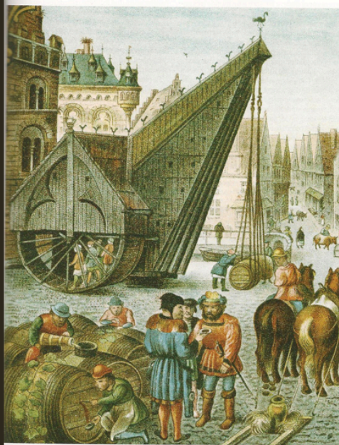
Port de Bruges Sur cette enluminure de Simon Bening du début du xvi e siècle, on peut voir, en arrière-plan, une grue de levage qui permet de transférer sur des moyens de transport terrestre des fûts de vin arrivés, parfois de très loin, par bateau.
