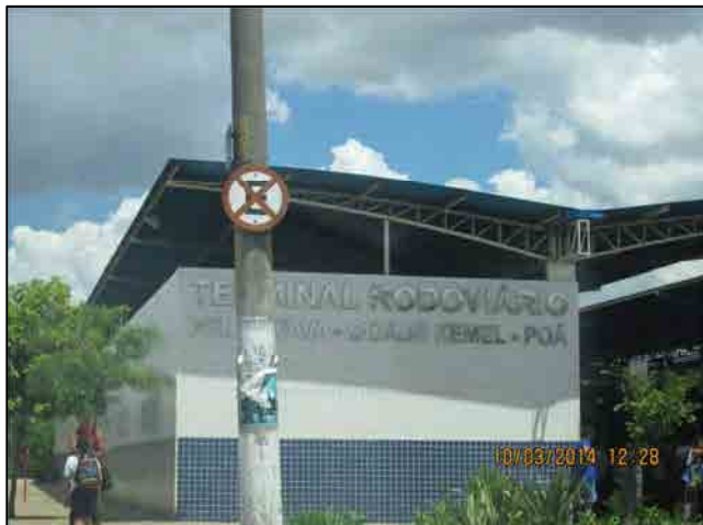
Foto 9.3.2.4-13 - Área de uso institucional instalada em Poá, a qual se integrará ao BRT Perimetral Alto Tietê.
