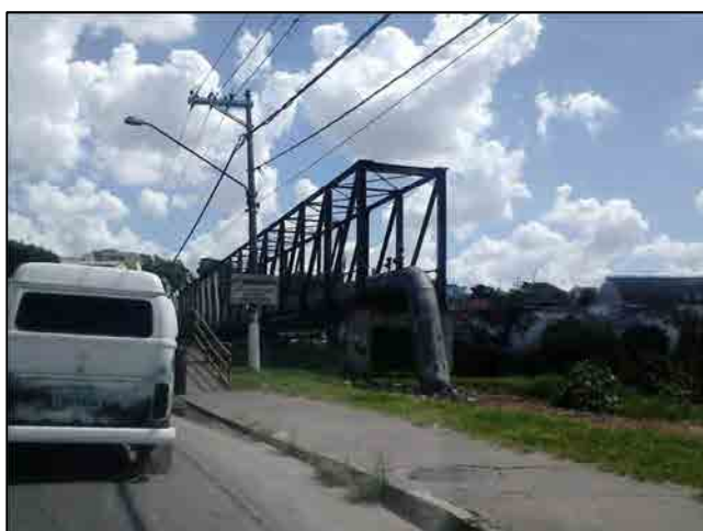
Foto 9.3.2.4-11 - Infraestrutura instalada nas proximidades do BRT Perimetral Alto Tietê em Itaquaquecetuba.
