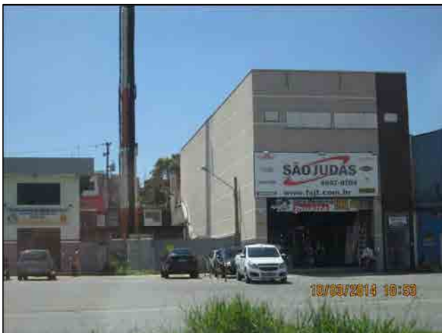
Foto 9.3.2.4-5 - Área dedicada a comércio ao lado de torre de celular (infraestrutura) em Itaquaquetuba
