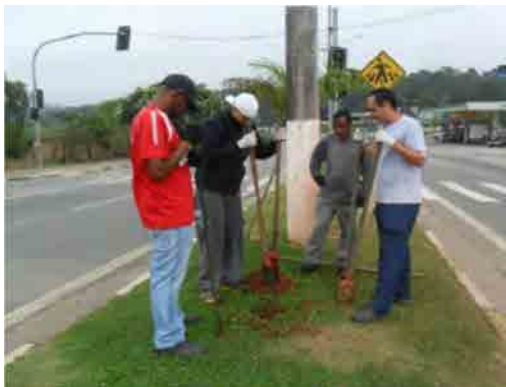
Foto 9.3.2.9-1: Procedimento de abertura do poço-teste
