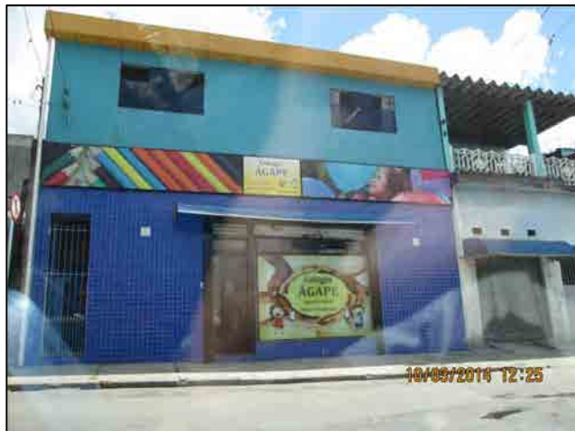
Foto 9.3.2.4-14 - Área de uso de serviços e residencial em Ferraz de Vasconcelos.
