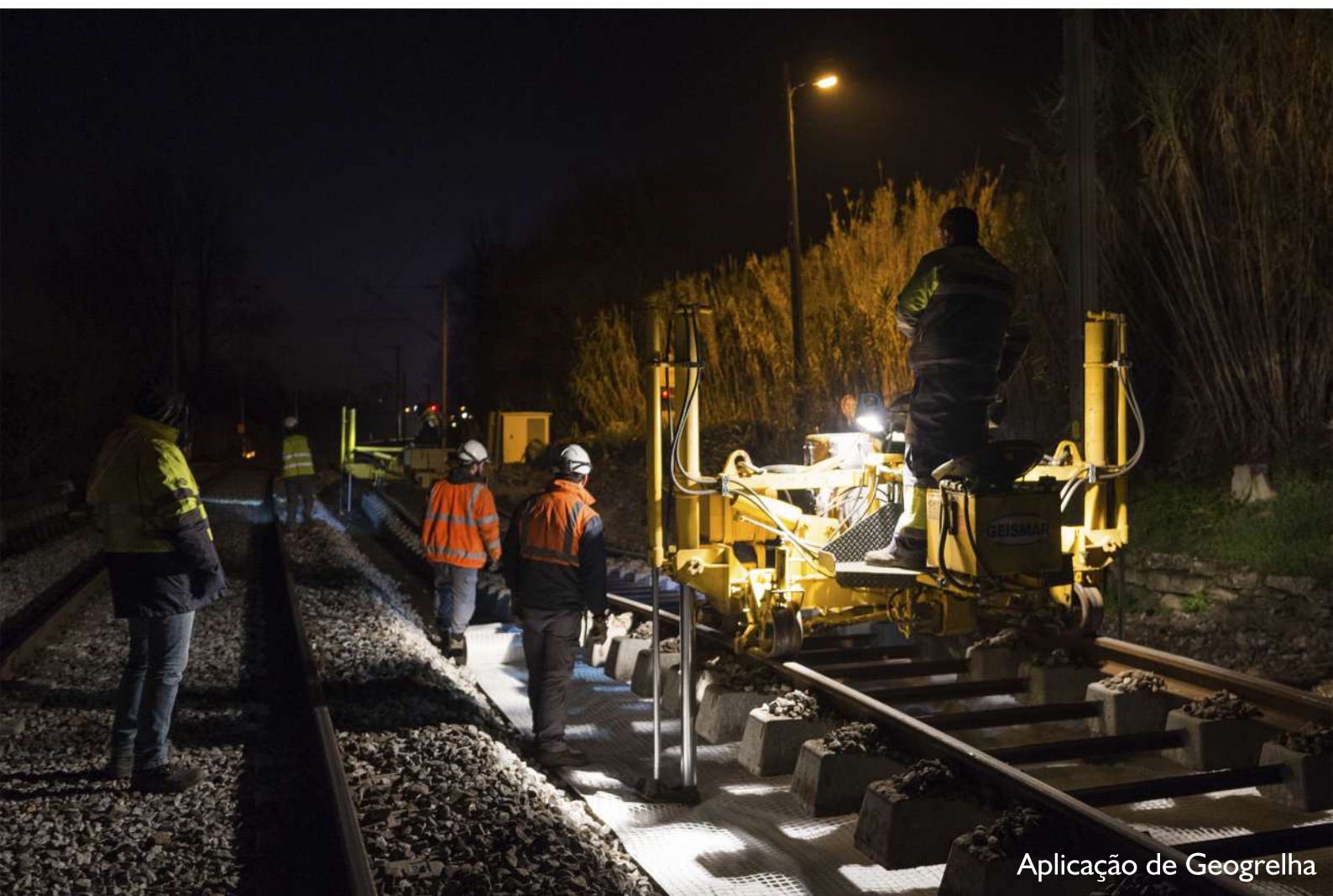
Renovação Integral de Via
