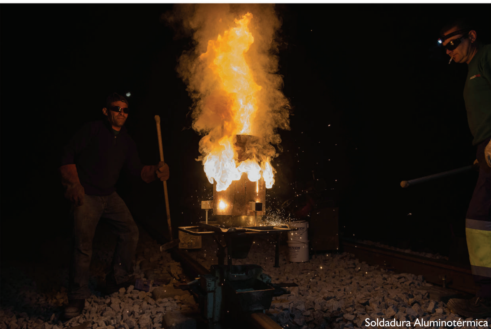
Preparação para Soldadura Aluminotérmica
