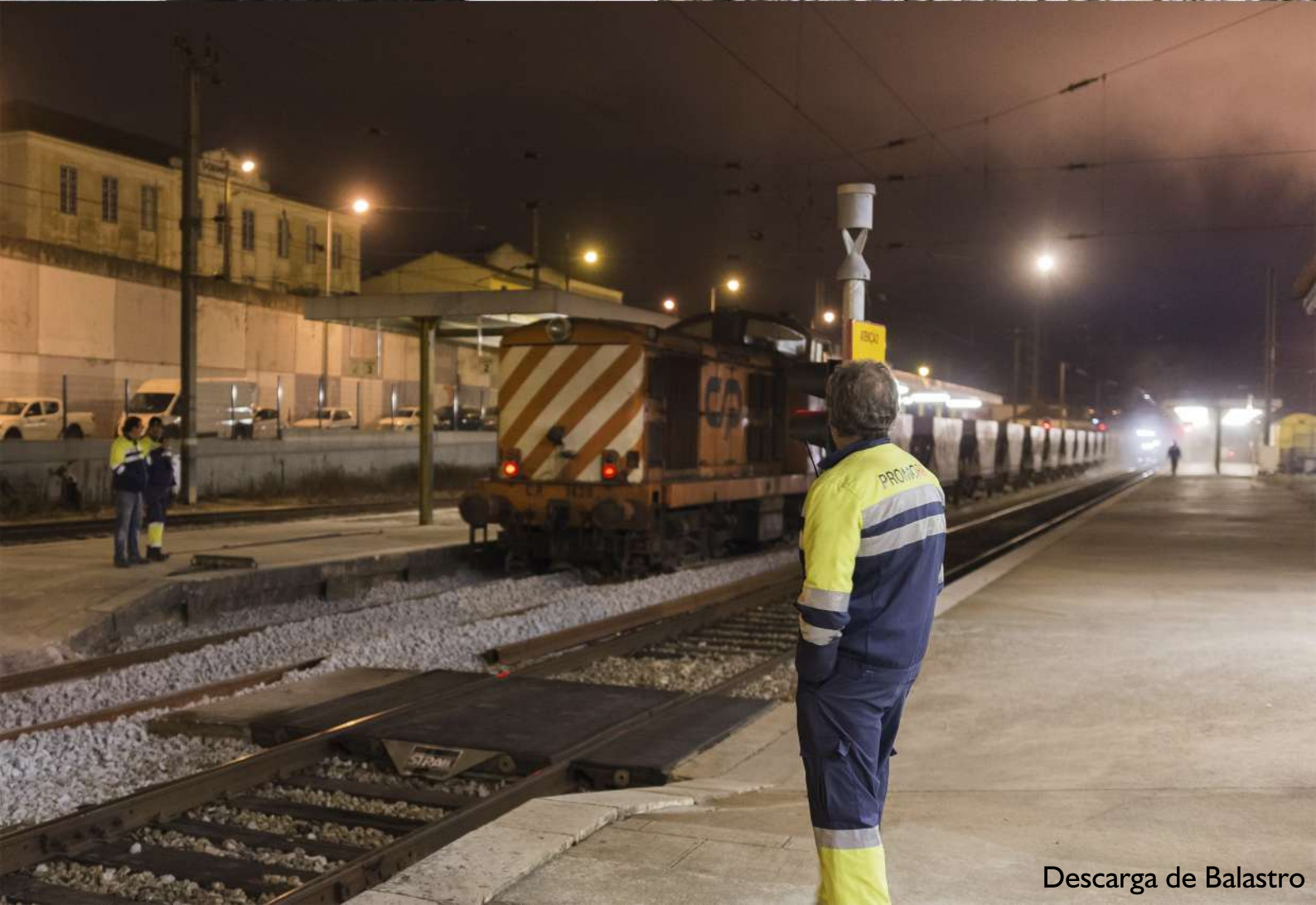
Renovação Integral de Via
