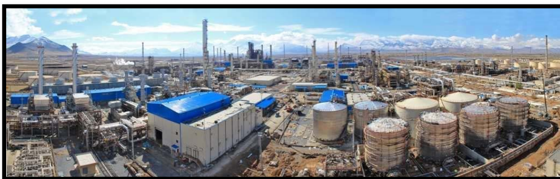
پالایشگاه امام خمینی شازند ( در حال اتمام ساخت 1390 )
